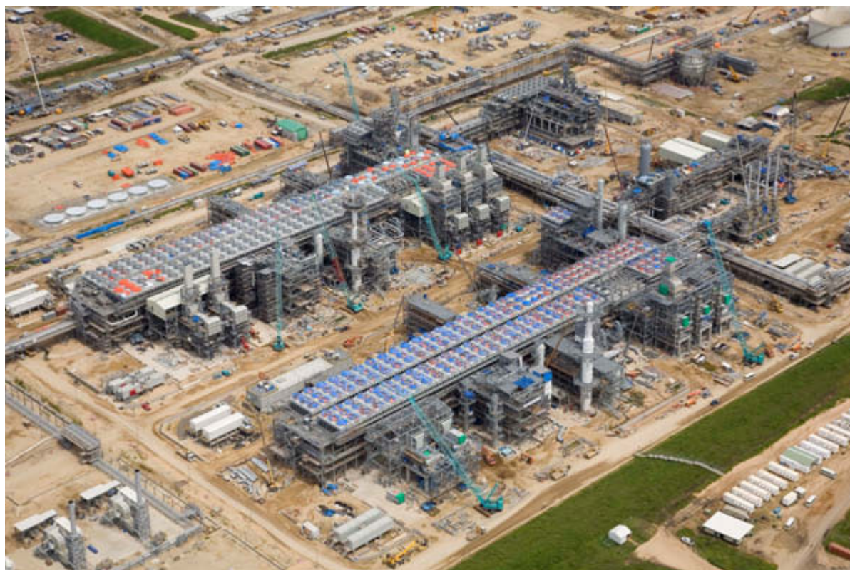
LNG plant site, March 2013
