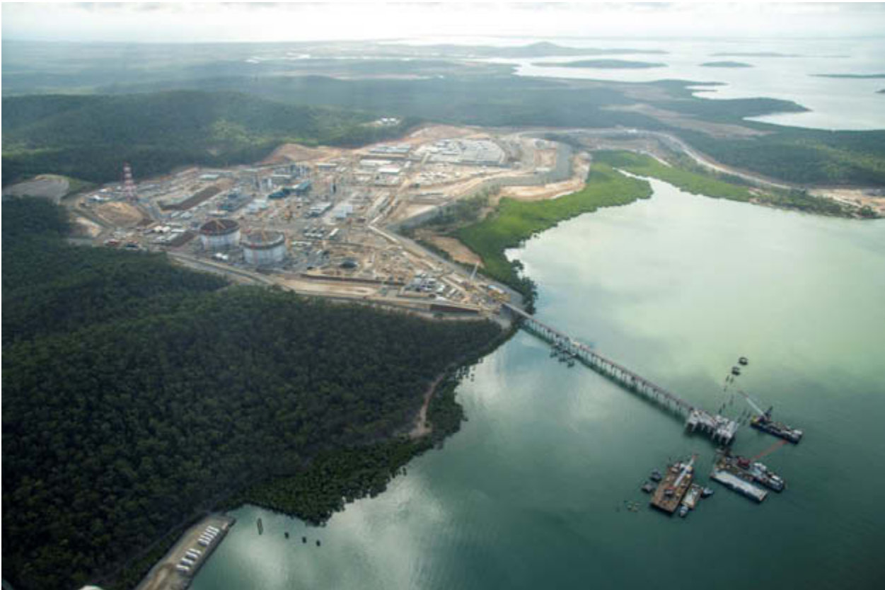
LNG plant site on Curtis Island, September 2013.
