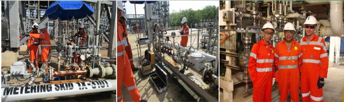
FIGURA 15: EKIPA SASUKAT HALA'O INSPESAUN IHA FASILIDADE DLNG
