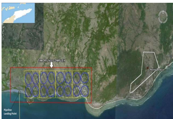
Fábrica de GNL em Beço
