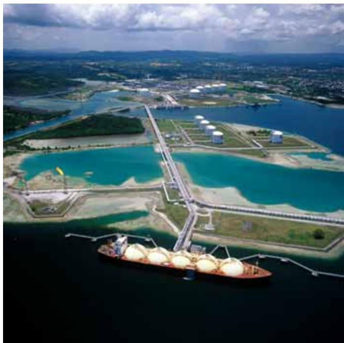
Bontang LNG Plant
